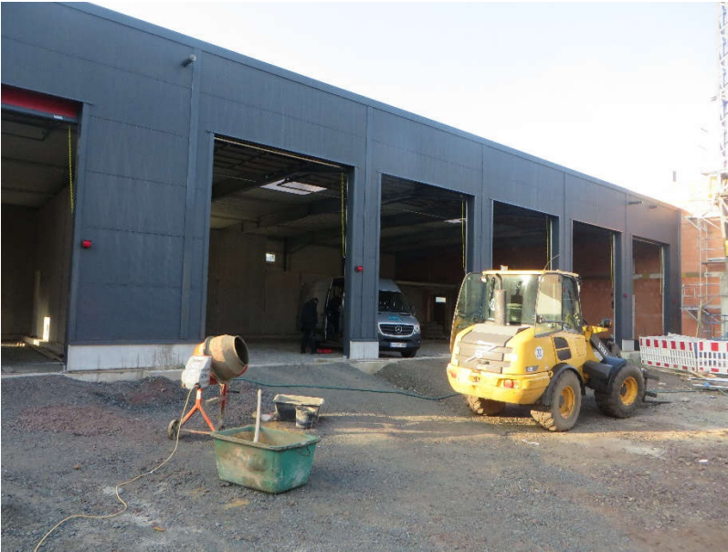
-Fahrzeughalle- Alarmhof - Ausfahrtbereich
