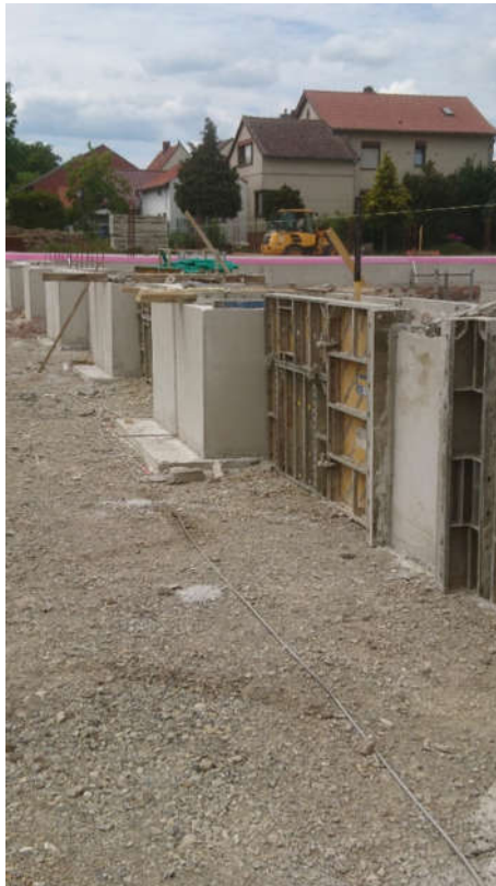
-Fahrzeughalle- Gebäudeansicht Süd Anordnung Schalttafeln für die Frostschrürze
