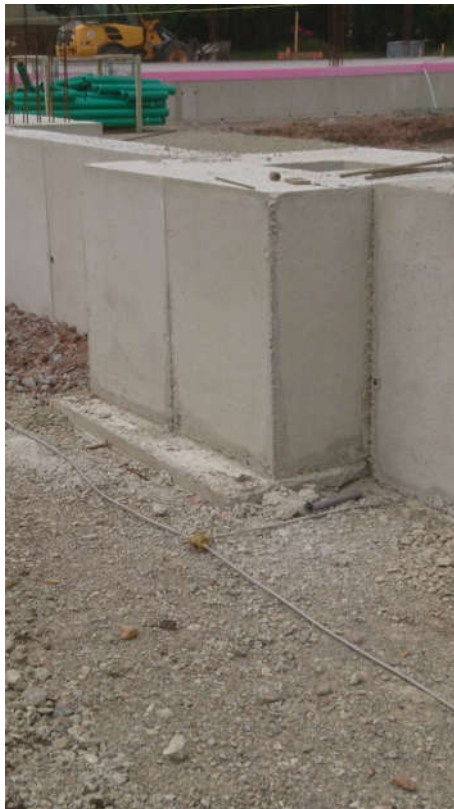
-Fahrzeughalle- Gebäudeansicht Süd Anordnung Köcherfunda- mente mit Beton- nester
