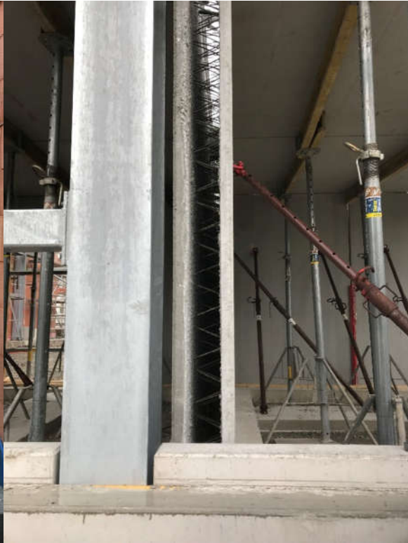
-Fahrzeughalle- Detail Filigranwände
