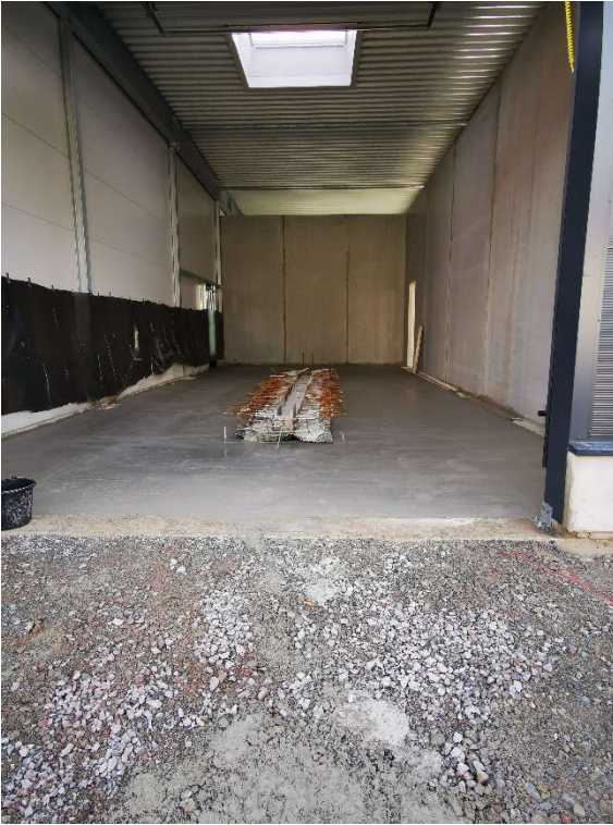
-Fahrzeughalle- Entwässerungsrinne Waschhalle
