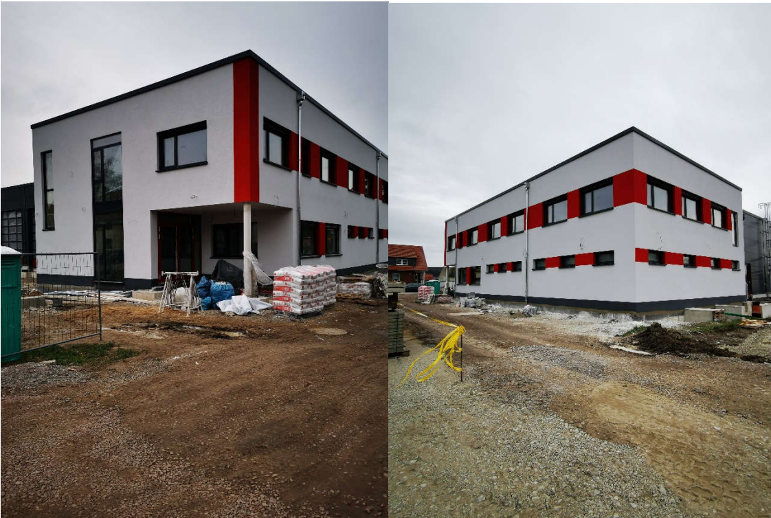
-Sozialgebäude- Gebäudeansicht Nordwest
