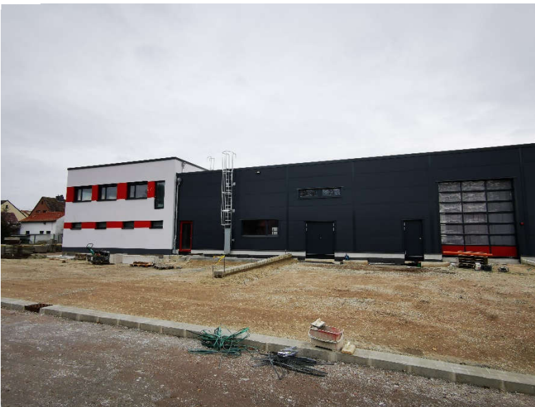
-Sozialgebäude / Fahrzeughalle- Gebäudeansicht Süd
