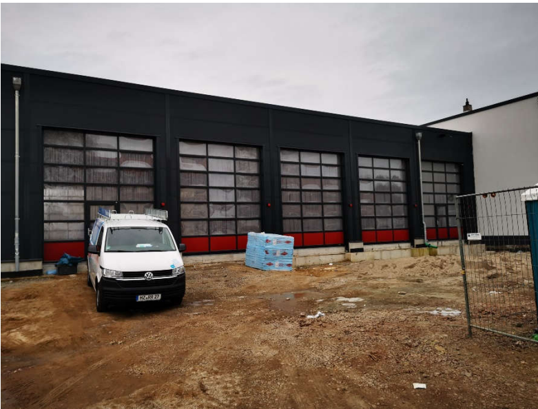
-Fahrzeughalle- Gebäudeansicht Nord
