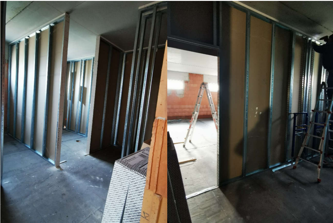
-Sozialgebäude- Trockenbauarbeiten Umkleide Herren
